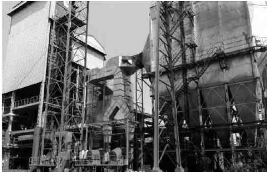
படம் 2-10 எலக்ட்ரோஸ்டேடிக் ப்ரெசிபிடேட்டர்
