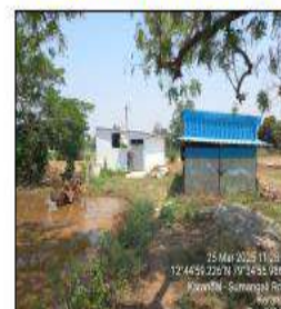
S8- Motor Room- 263m (NW)
