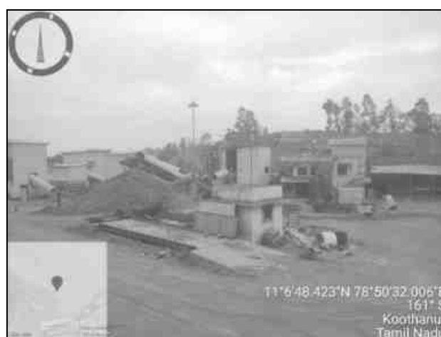
S1- Crusher Unit- 85m(SW)
